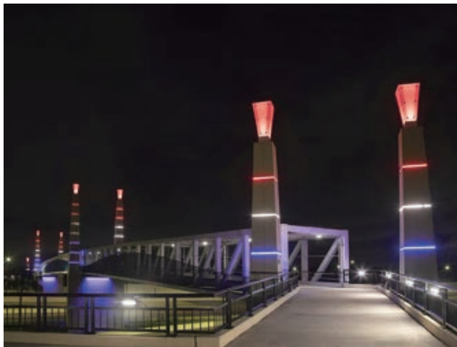
この歩行者専用橋は、フロリダ州のInterstate 4を横断する、Maitland Boulevard上の利用者の多い歩道をつないでいる
