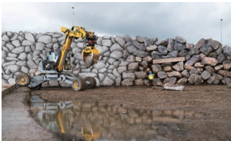
図1 メンツィムック社製の作業機械が、巨石を1つずつ取り上げてスキャンし、壁を構築した
