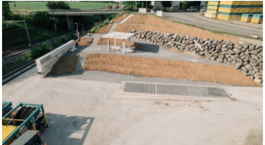
図2 サーキュラリティ公園の擁壁の航空写真
