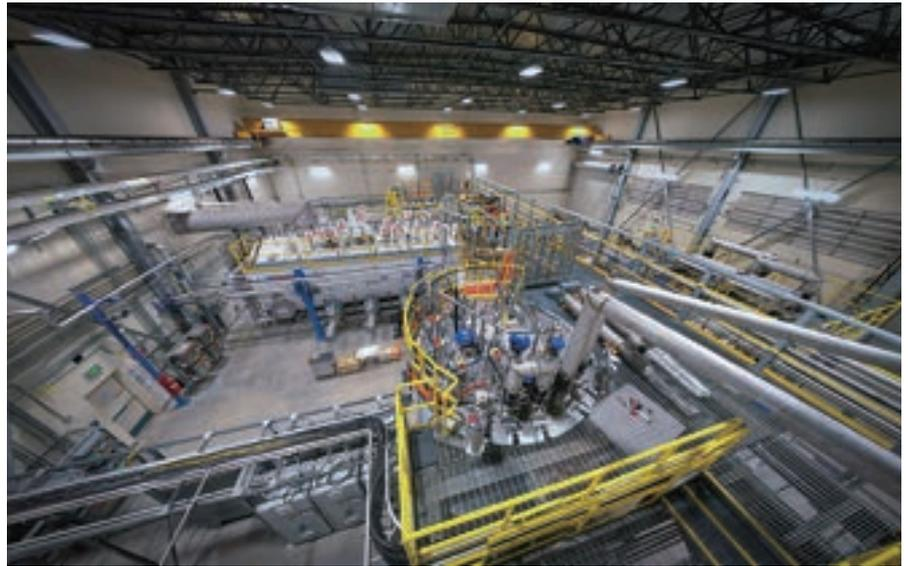
このクライオプラントは、ヘリウムを（宇宙空間よりも低温の）2ケルビンに冷却する。ヘリウムはその後、超伝導共振器を実現するためのLCLS加速器極低温モジュールの冷却に用いられる（画像提供：SLAC国立加速器研究所のオリヴィエ・ボニン氏 [Olivier Bonin]）
