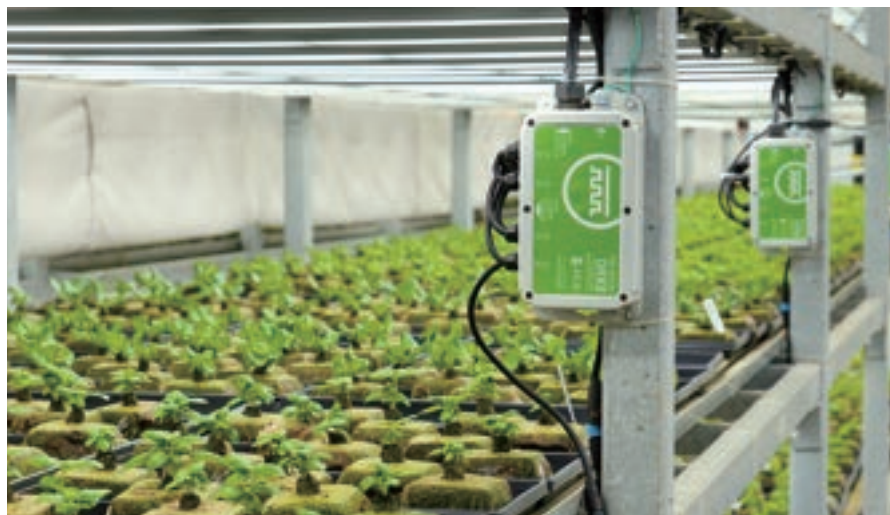
ハーディ・フレッシュの施設に設置されているこの写真のようなレシーバーは、湿度の高い栽培環境にあるLED照明器具やその他のハードウェアに、DC電力を安全に分配する
