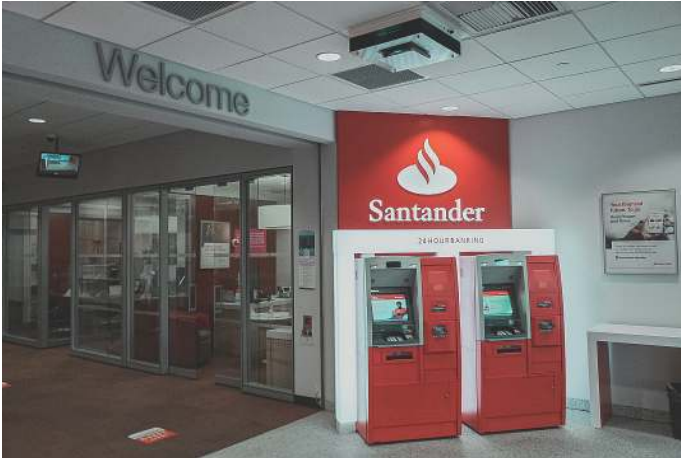
図3 エラピー社の「Zone 360」のような天井取り付け型の上層空気システムは、360°方向にUV-Cを照射することができる。写真は、銀行に設置された同製品である。(写真提供:エラピー社)
