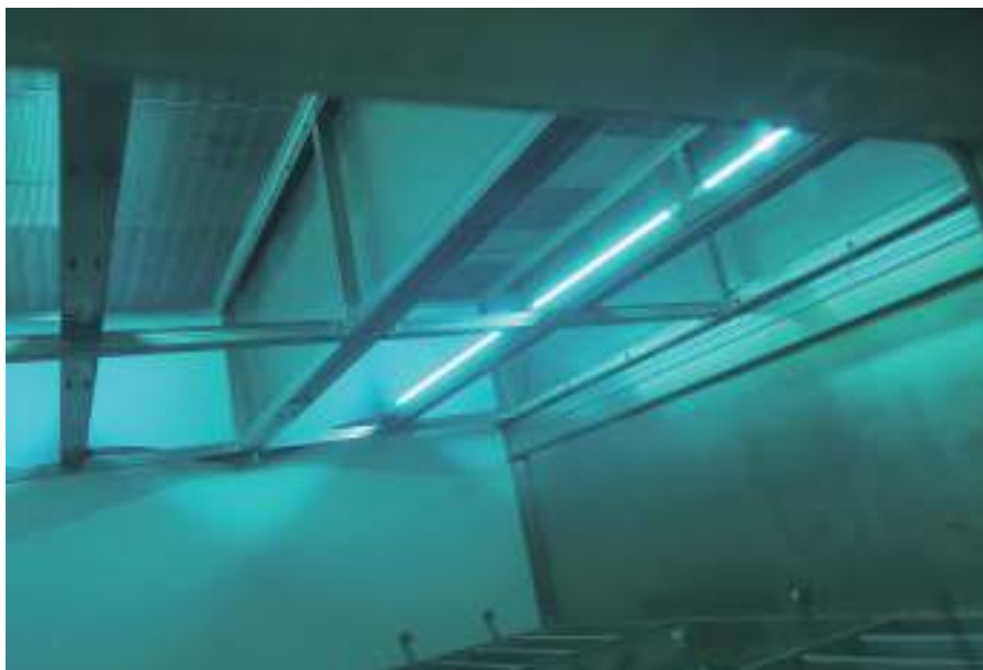
図3 UV-CランプをHVACシステムに組み込むことにより、空気中の病原菌を不活性化させることができる。また、コイルを清潔に保ち、システム運用の効率化にも効果があることが実証されている。(写真提供:ヘンリー・フォード・ヘルス・システム)
