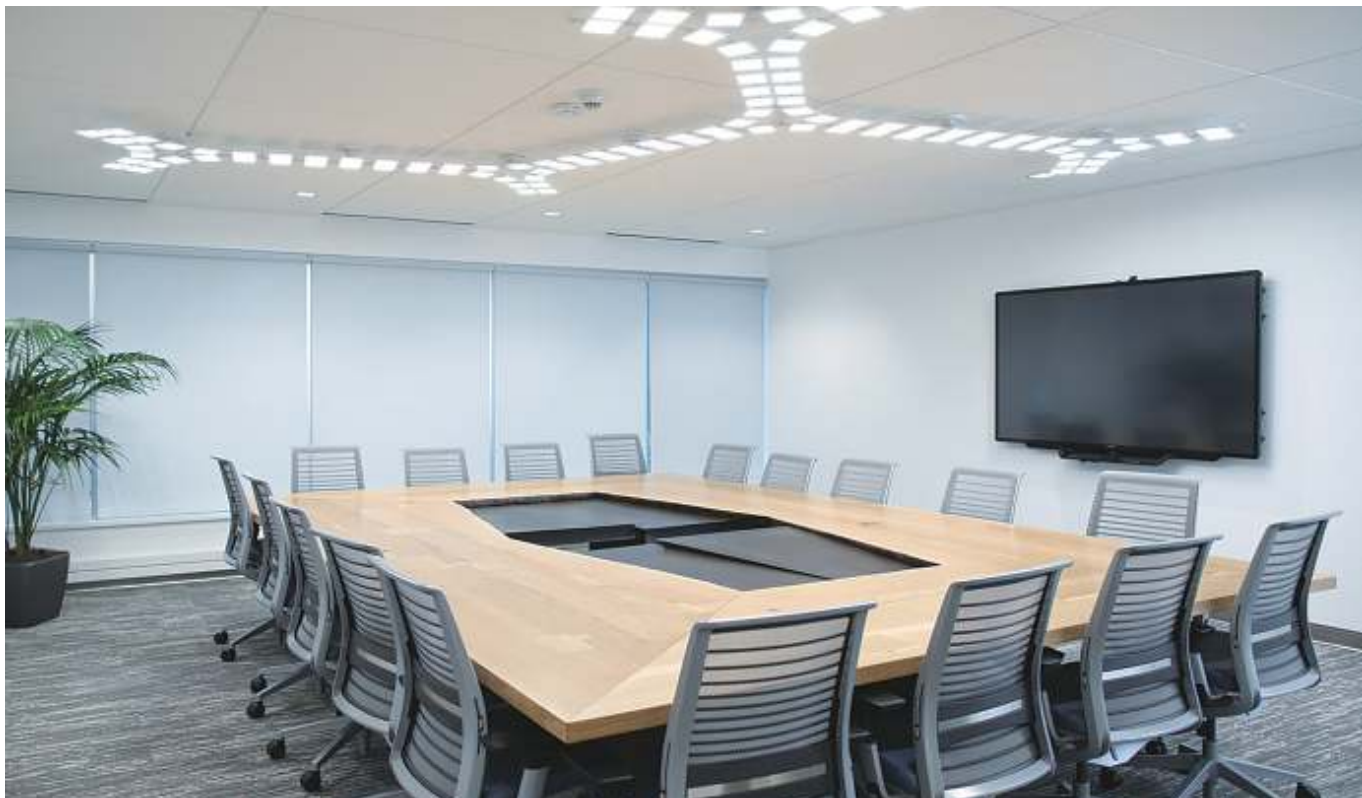
有機ELは、青色波長のエネルギーが少ない光を供給可能で、バイオリズムを支えるヒューマンセントリックライティング (HCL：人に優しい照明) 設計において、有効となる可能性がある。(写真提供：アキュイティエー・ブランズ社)
