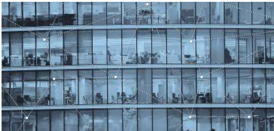
Bluetooth メッシュネットワークにより、照明を主要なネットワークノードとして使用する場合は特に、ビルシステム全体が秩序ある形で通信可能となる。(写真提供: Bluetooth 特別部会)
