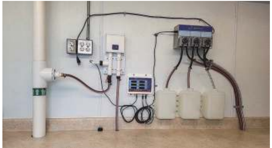
図3 水と養分の混合物が、それを供給する植物の種類に応じて常にテストされ調整される。
