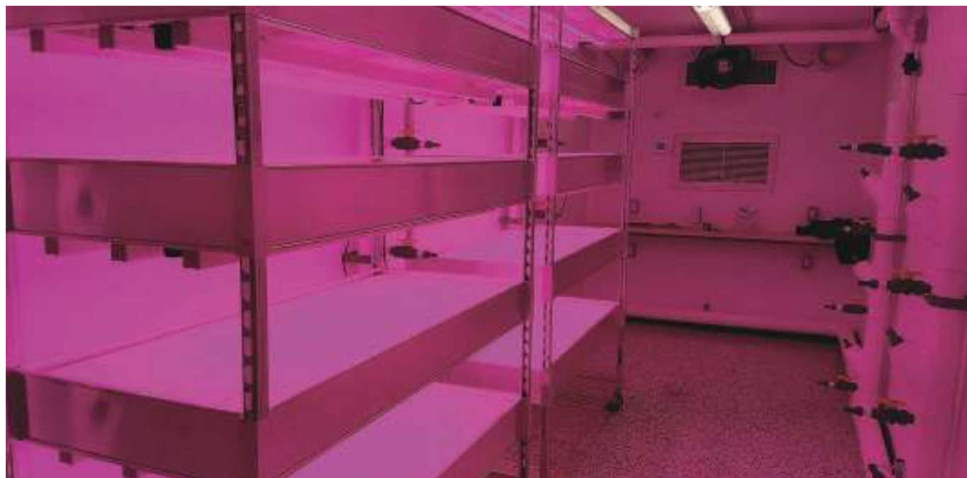
図2 Growtainerの片側に設置された栽培ラックを示した、組み立て中の写真。ラックがない右側に、カスタマイズされた養分と水の混合物を各ラックに供給するための配管設備がはっきりと確認できる。
