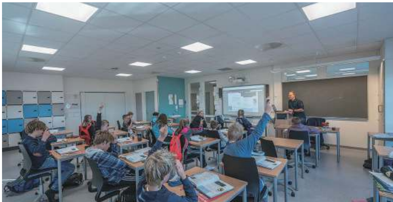
図1 教室には主に、チューナブルホワイト機能を備えるグラモックス社のトロファ照明「C90-R」が設置されている。
