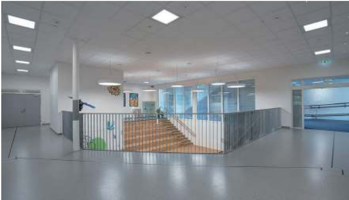
図2 娯楽エリアと廊下は、固定CCTのトローファ照明によって照らされている。
