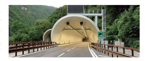
LED 照明は演色指数(CRI: Color Rendering Index)が比較的高いため、さんさんと照りつける太陽の光からトンネル照明への切り替わりがドライバーにとって格段にスムーズになるという。さらに、新しい照明は最大出力の75%で動作可能で、それでも規制要件を満たす。同システムは14万時間稼働すると見込まれている。
