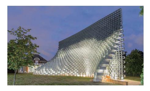
フレームを積み上げる形で構成されて おり、インゲルス氏が目指したのは、 ベースから発せられた光が壁をつたい 上がって建造物を浮き上がらせるよう な照明効果だった。照明は頂上で薄暗 くなり、暗い夜空に溶け込んでいく。 照明器具は視界から見えないように工 夫されている。エンジニアリング企業 の米エイコム社(Aecom)とツムトーベ ル社のチームが照明設計を担当した。 エイコム社は、地上に100ルクス、バ ーに200ルクス、非常口に平均10ル クスが必要と仕様を定めた。ツムトー ベル社は、長方形のファイバグラス要 素の光透過特性を測定した上で設計を シミュレーションし、ファイバグラス の光特性、壁が内側に傾いていること、 そして光レベルを高くした場合にグレ アが生じる可能性があることから、ア ップライトだけでは必要な光レベルが 得られないとの結論に達した。最終的 に同チームは、周囲のベンチ席の背後に 隠された照明器具からアップライトを当 てることと、地上から4.3mの高さに acdcのスポットライト「Plaza 10」を いくつか配置することにした。ベンチ
