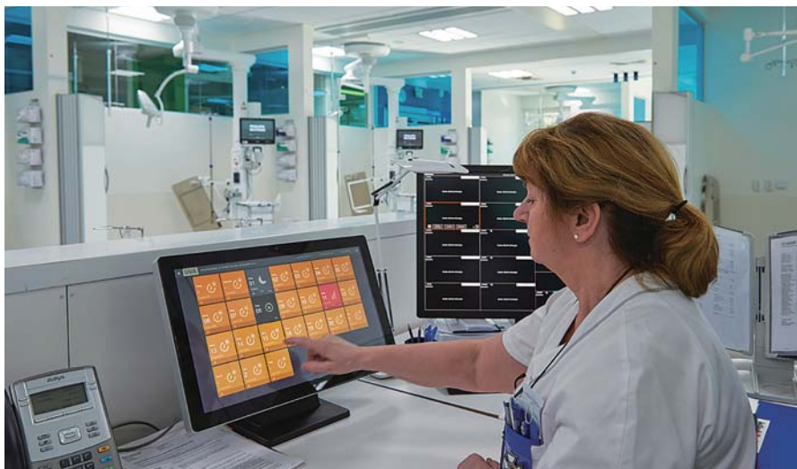
図4 スウェーデンのカールスタードの病院職員は、照明モードを変更して柔軟な患者ケアを提供することができる。例えば、適切な光のレベルとスペクトルをプログラムして、患者の睡眠と起床の自然なサイクルを乱すことなく、検査を行うことができる。
