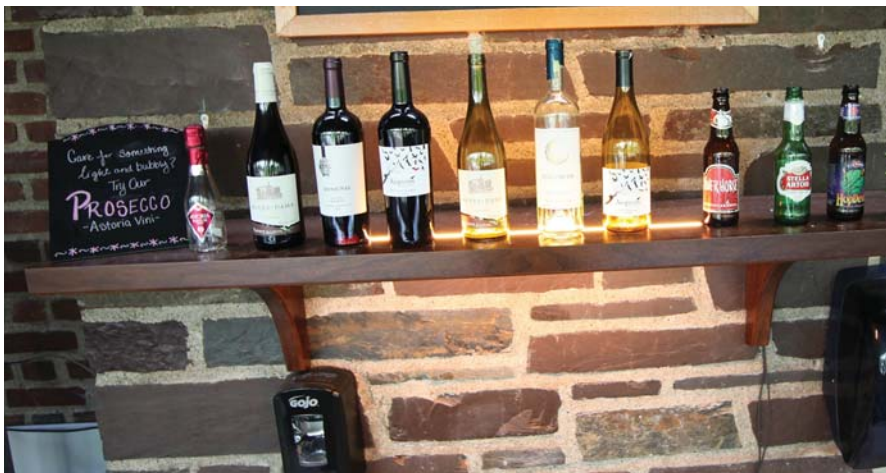
図2 棚やキャビネット下に設置された照明は、直列接続またはDCバスを介して接続可能なDC給電照明の1例である。
