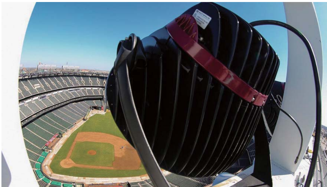
図3 エフェソス社の照明製品「Stadium Pro」では、ドライバ電子回路とネットワーク制御がLEDライトエンジンとともにその筐体内に統合されている。(写真提供:テキサス・レンジャーズのケリー・ゲービン氏 (Kelly Gavin))
