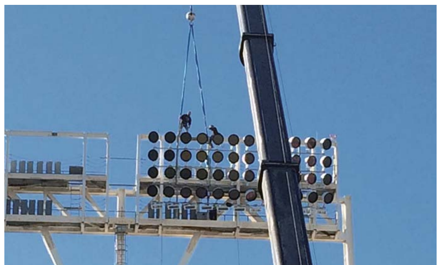
図4 ムスコ社はサンディエゴ・パドレスと協力して、新しいLED照明ラックを一から組み立て、完成したラックをペットコパークの上部までつり上げた。(写真提供:サンディエゴ・パドレス)
