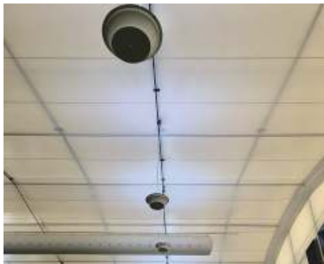
図2 比較的軽量なLED照明器具である「Eclipse」は、エアドームから安全に吊り下げることができる。(写真提供:グリーン・アーク・エナジー・アドバイザーズ社)
