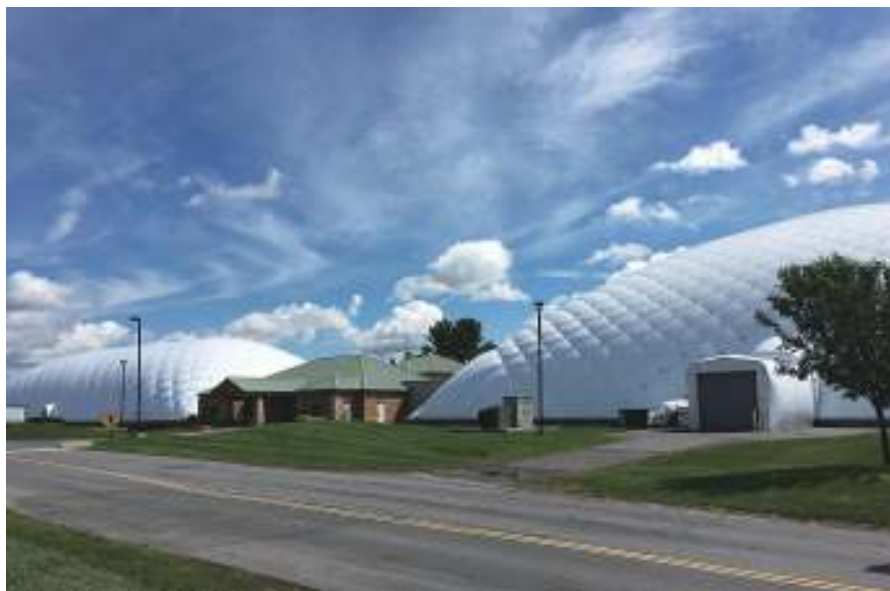
図3 ニューヨークにある1万7000平方フィート(約1579m 2 )のゴルフ練習施設を覆う空気支持型ドーム。(写真提供:グリーン・アーク・エナジー・アドバイザーズ社)
