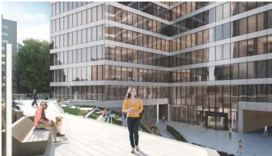
図3 半透明ペロブスカイトソーラセルは、簡単にビル外観に組みこまれ、電気を生成する。(提供: サンスカ社)
