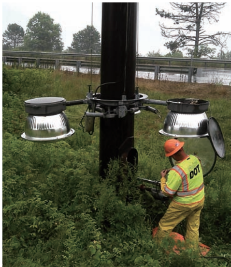
図2 ハイマスト照明器具を引き下げて工事を行う作業員。
