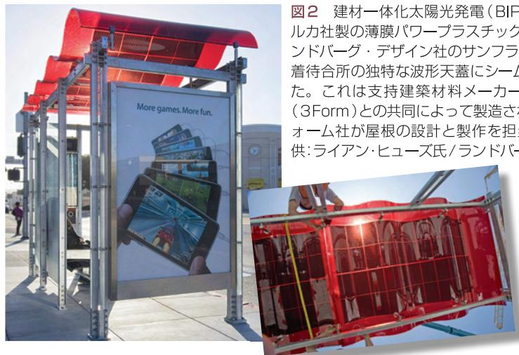
図2 建材一体化太陽光発電(BIPV)としてのコナルカ社製の薄膜パワープラスチック(挿入写真)はランドバーグ・デザイン社のサンフランシスコMTA発着待合所の独特な波形天蓋にシームレスに統合された。これは支持建築材料メーカーの3フォーム社(3Form)との共同によって製造されたもので、3フォーム社が屋根の設計と製作を担当した。(資料提供:ライアン・ヒューズ氏/ランドバーグ・デザイン社)
